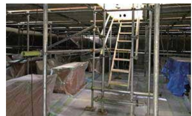
改修中の様子
