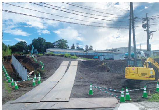
菊陽北小学校造成工事の様子
