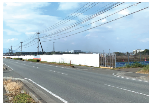
造成工事が進む(仮称)第二原水工業団地
